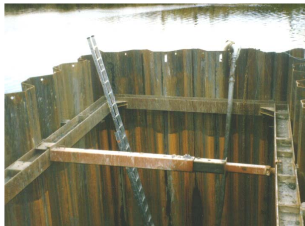
Bau des Auslaufbauwerkes in die Lippe
