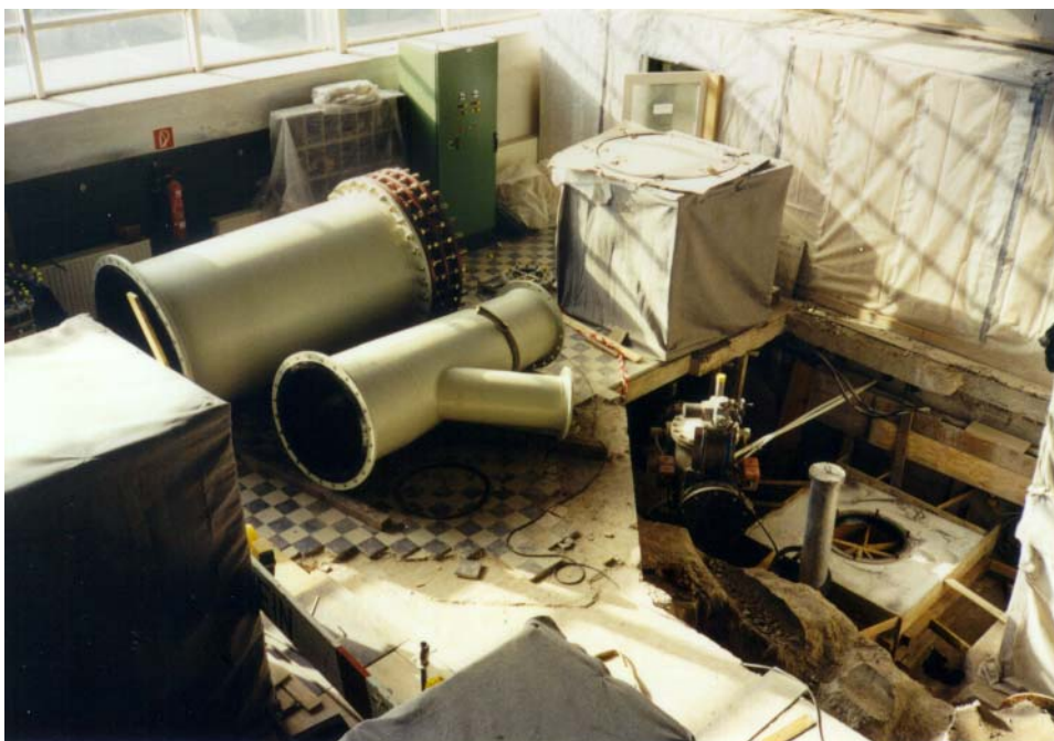
Erneuerung Druckrohrleitungen im Maschinenraum
