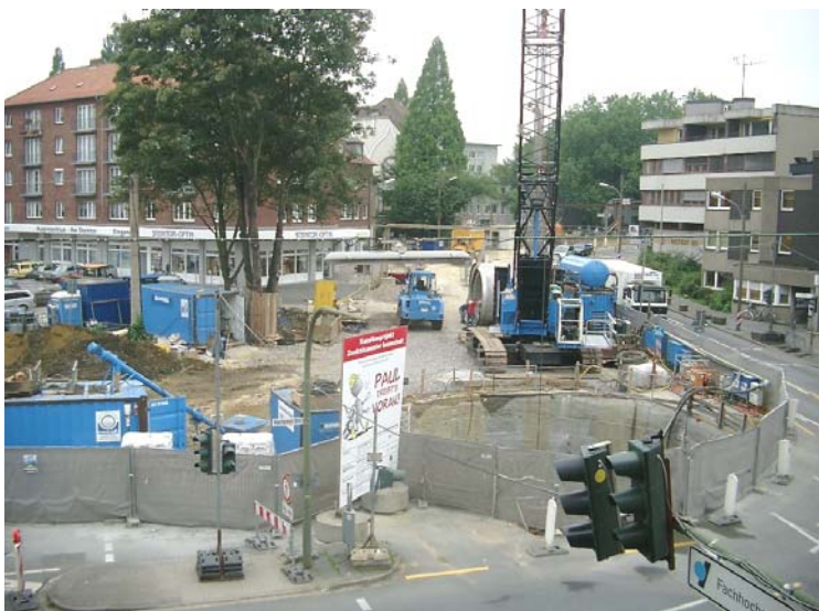
Blick auf die Pressbaugrube im Königswall direkt im Innenstadtring Recklinghausens (d = 13m, t = 12m)
