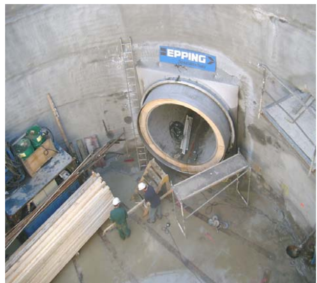
Blick auf die Pressbaugrube im Königswall direkt im Innenstadtring Recklinghausens (d = 13m, t = 12m)
