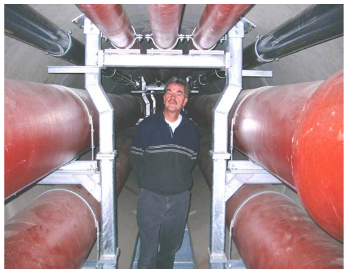
Begehung des fertiggestellten Vortriebs DN 2400 unter der B227
