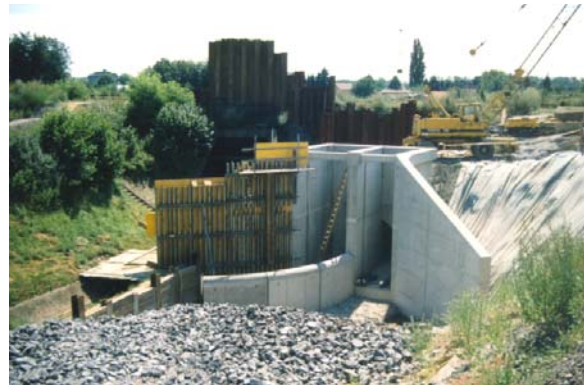
Auslaufbauwerk mit Überlaufschwelle
