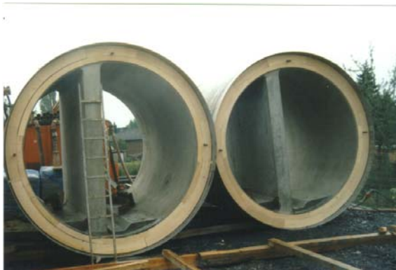
Vortriebsrohr DN 2600 mit außermittiger Trennwand
