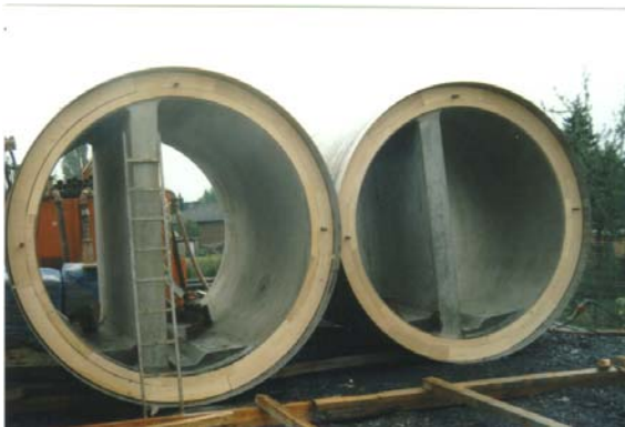
Vortriebsrohr DN 2600 mit außermittiger Trennwand
